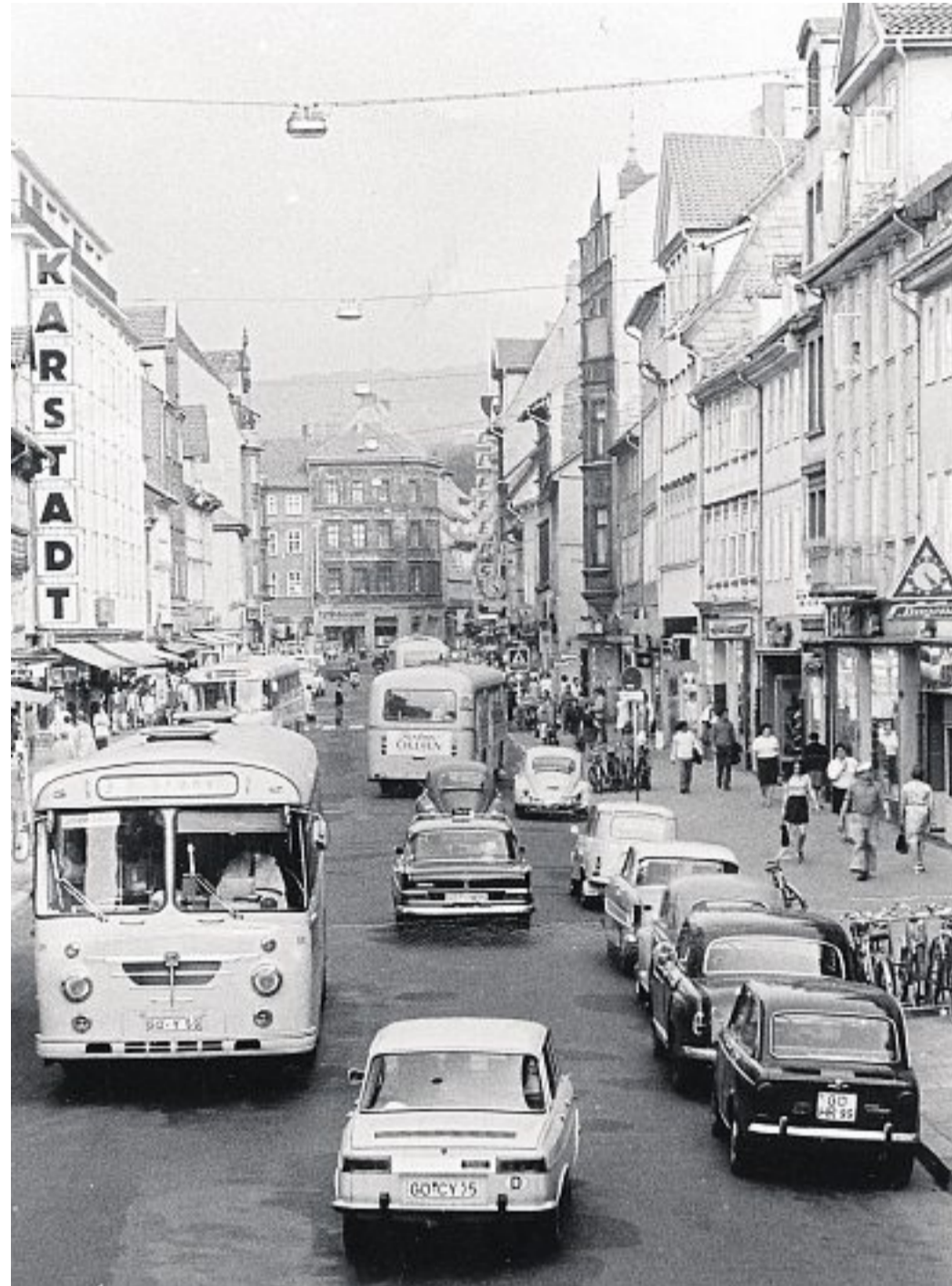
Groner Straße: Die Geschäfte können noch per Auto angesteuert werden. Städtisches Museum
